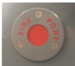
Orificio de extinción ubicado en el lado de babor de la consola.
